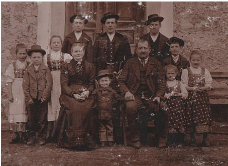
Altes Foto: ausgebleicht mit Schäden
